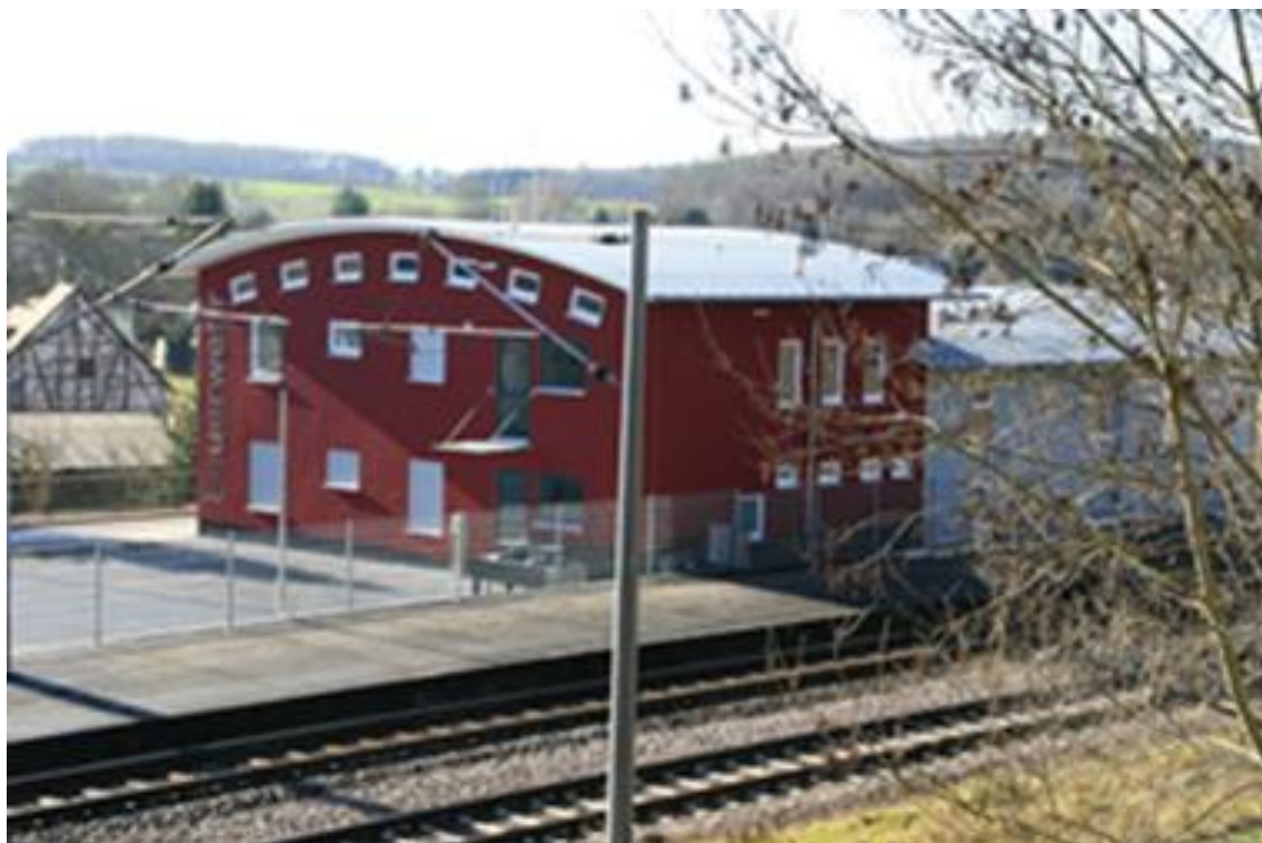
Abbildung 7: Neues Feuerwehrgerätehaus Wössingen bei der Bahn
